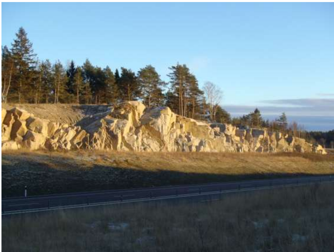
Figur 74. På denna del av sträckan fanns inga kontinuerliga vertikala sprickplan att följa, vilket resulterade i en mer orolig slänt. För att undvika att framtida nedfallande block kan komma ut på vägen finns en horisontell hylla vid släntfot som omöjliggör detta.
