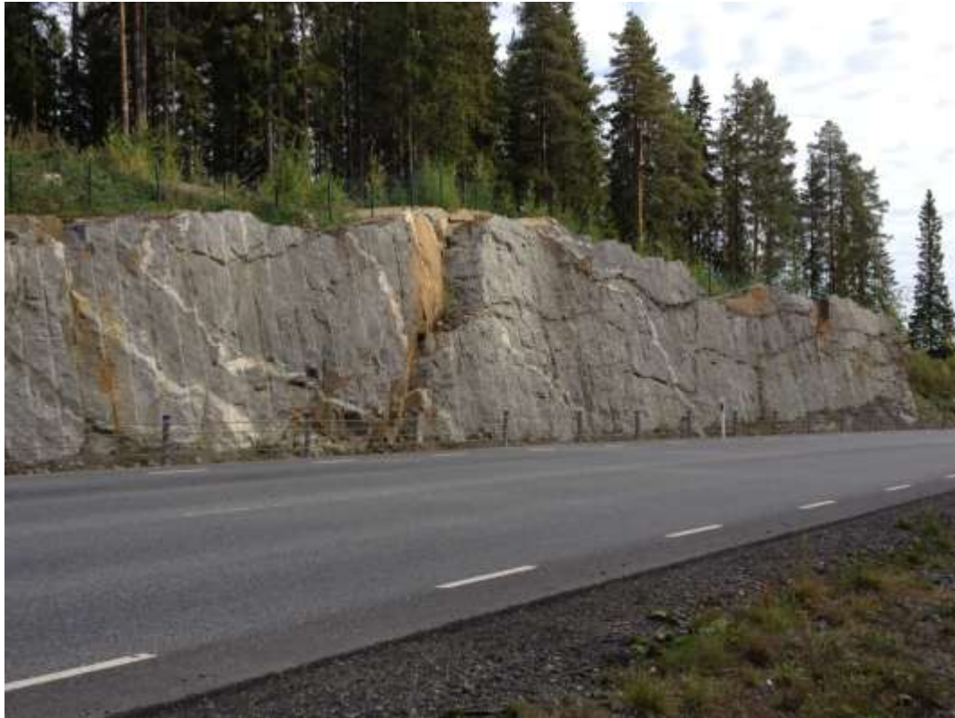
Figur 77. Kontursprängning i motsvarande bergart som i Figur 75-76, med ett bättre resultat.
