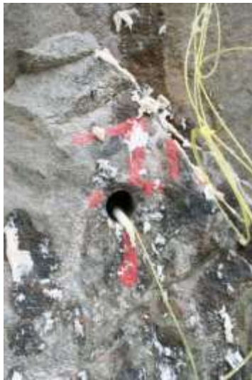
Figur 65. Spill från strängemulsionsladdning av tunnelsalva
