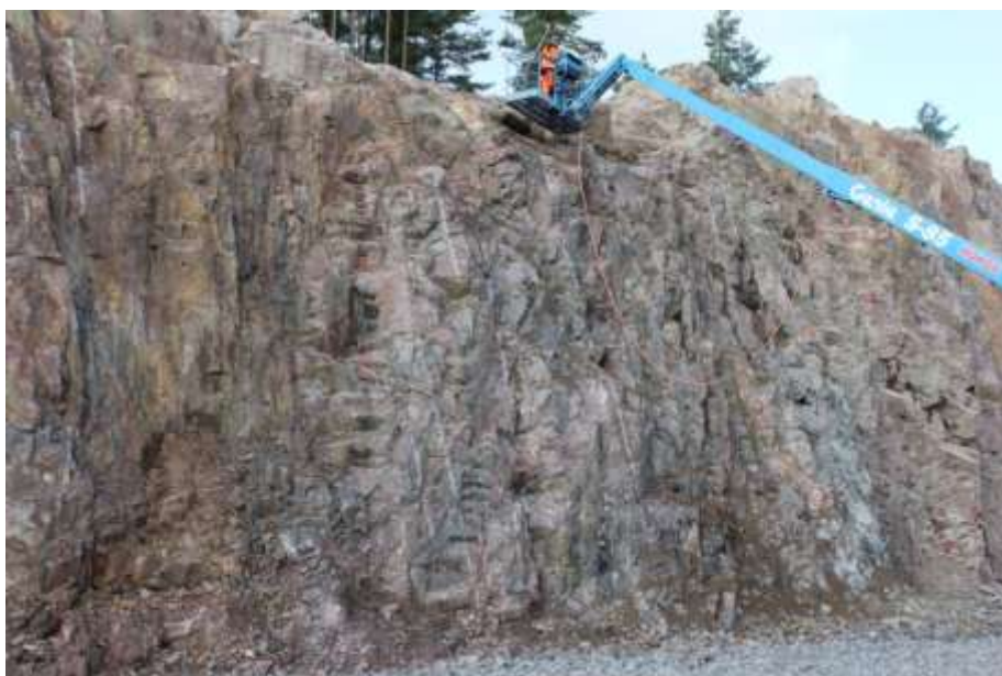
Figur 7. Dålig kvalitet på bergskärning
