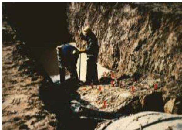
Figur 31. Laddning av rörgrav (Olofsson)
