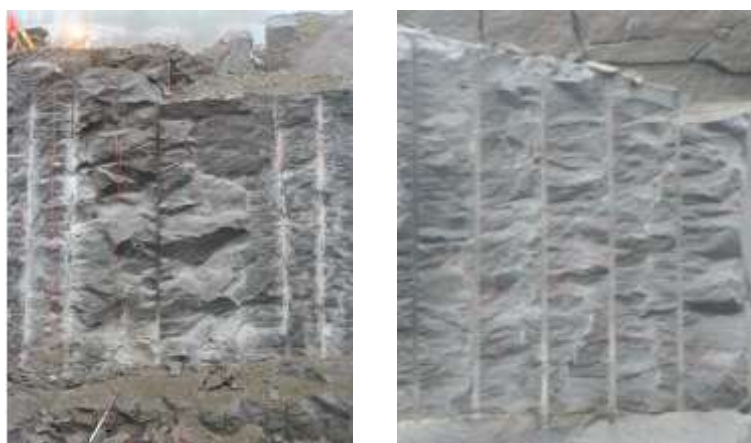
Figur 40. Ej momentan sprängning (vänster bild), momentan sprängning (höger bild)
