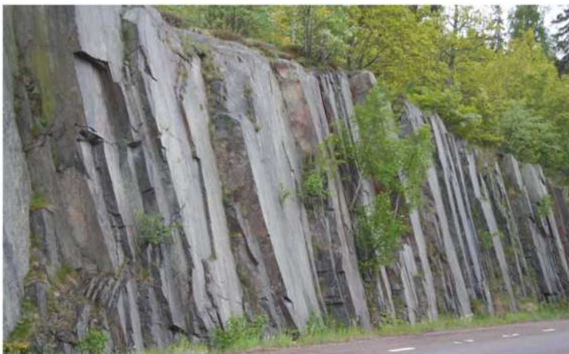
Figur 70. Här har den befintliga förskiffringen i berget utnyttjats på ett mycket bra sätt. Ett visst bultbehov kan dock finnas här för att säkra upp mindre block.
