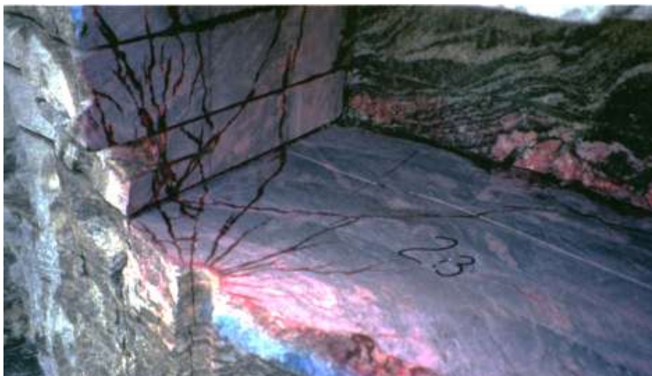
Figur 41. Sprängning av konturrad i vägs kärning
