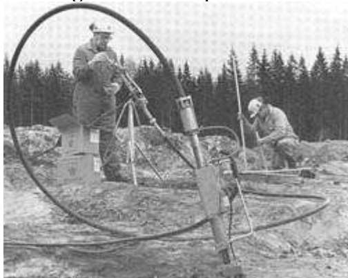
Figur 8. Laddning med pneumatisk laddapparat (Olofsson)
