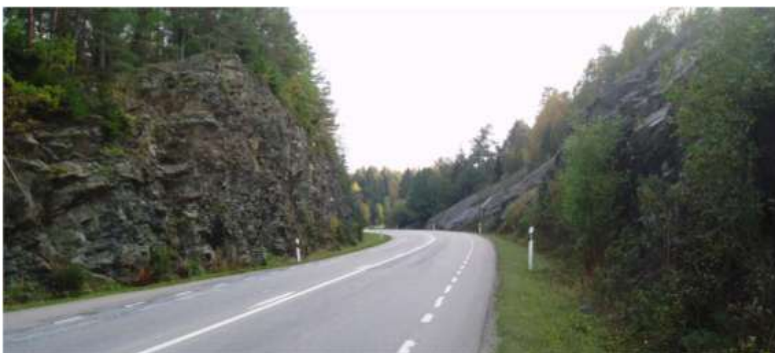
Figur 71. Så här kan resultatet bli om man utför en dubbelsidig bergskärning i en gnejs med tydlig förskiffring.
