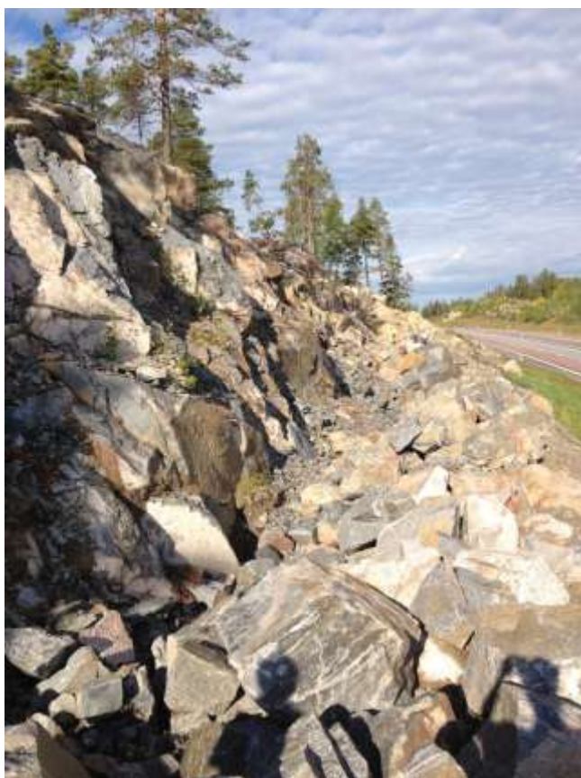
Figur 76. För att undvika att blocken trillar ut på vägen har man grävt ett dike i släntfoten. Hur länge dröjer det innan diket är fullt?
