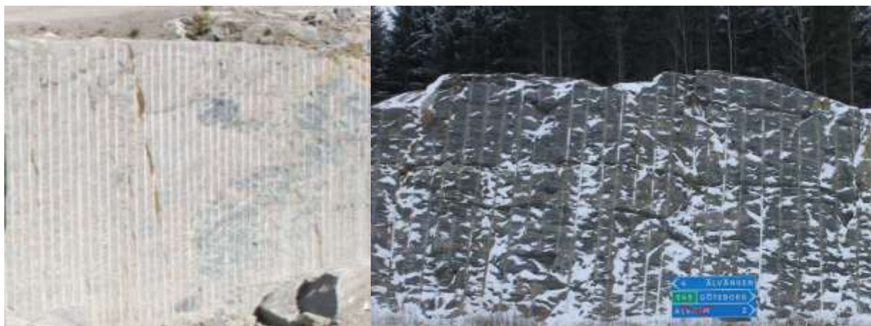
Figur 36. Några exempel på förspräckning (högra bilden är aktivt förspräckt)
