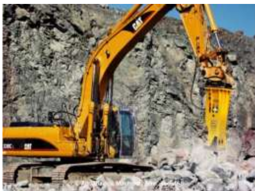
Figur 54. Sönderdelning av skut med hydraulisk berghammare
