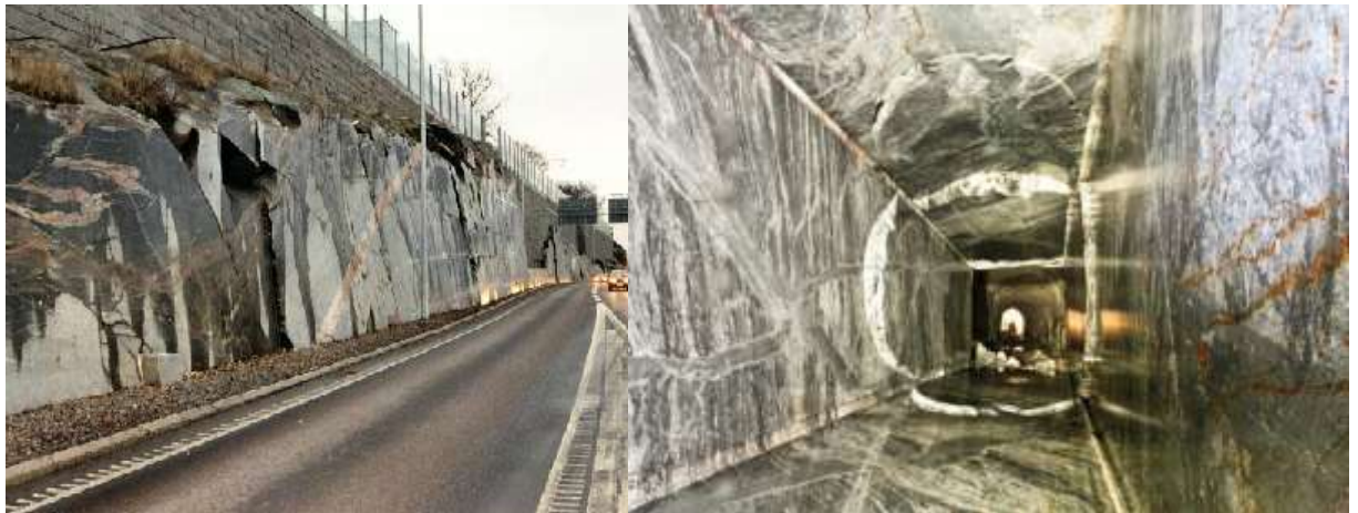
Figur 58. Resultat av wiresågning (Foto DWTeknik och EDZ-Consulting)
