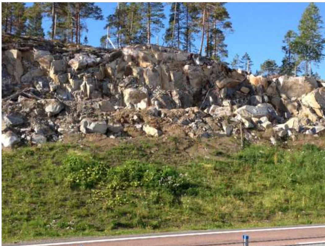
Figur 75. En "naturlik" bergskärning med mindre lyckat resultat.
