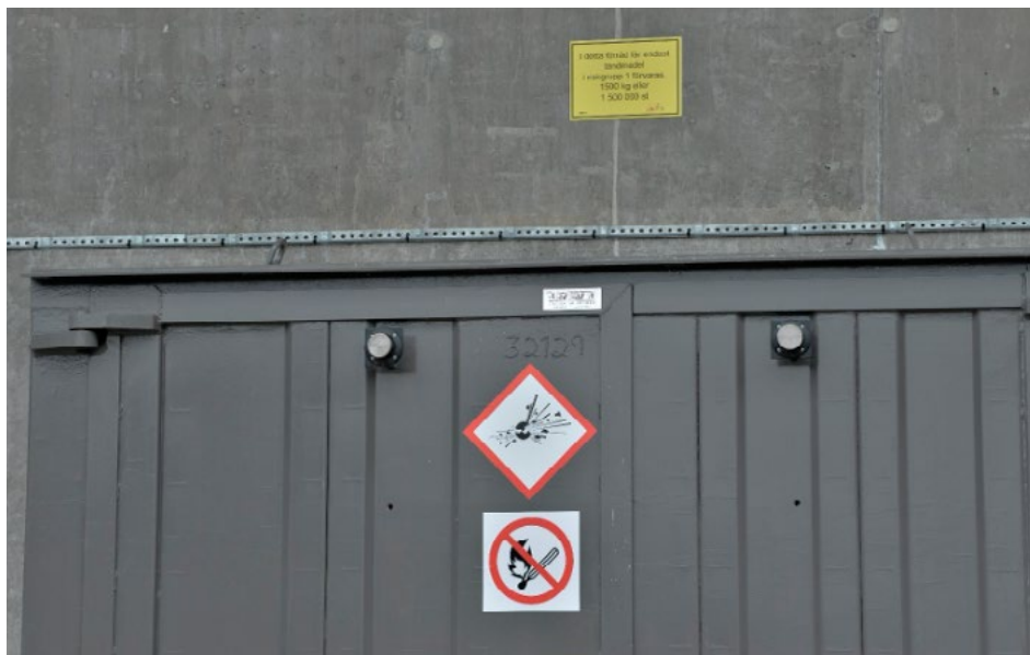
Bild 40: Skyltning av förråd för explosiva varor.
